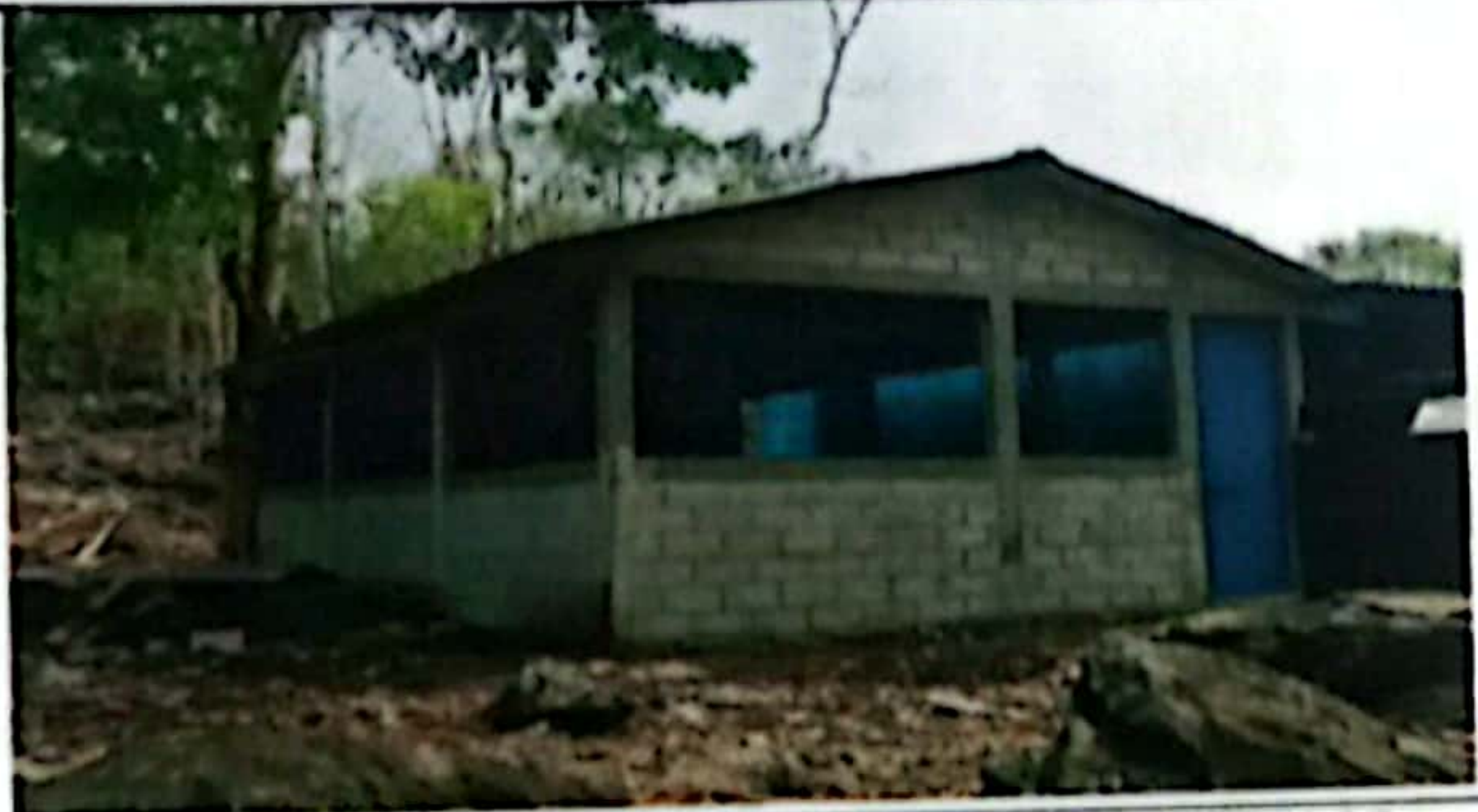
Foto1: LA INSTALACION ESTRUCTURA DE TECHO Y CUBIERTA DE LAMINA
