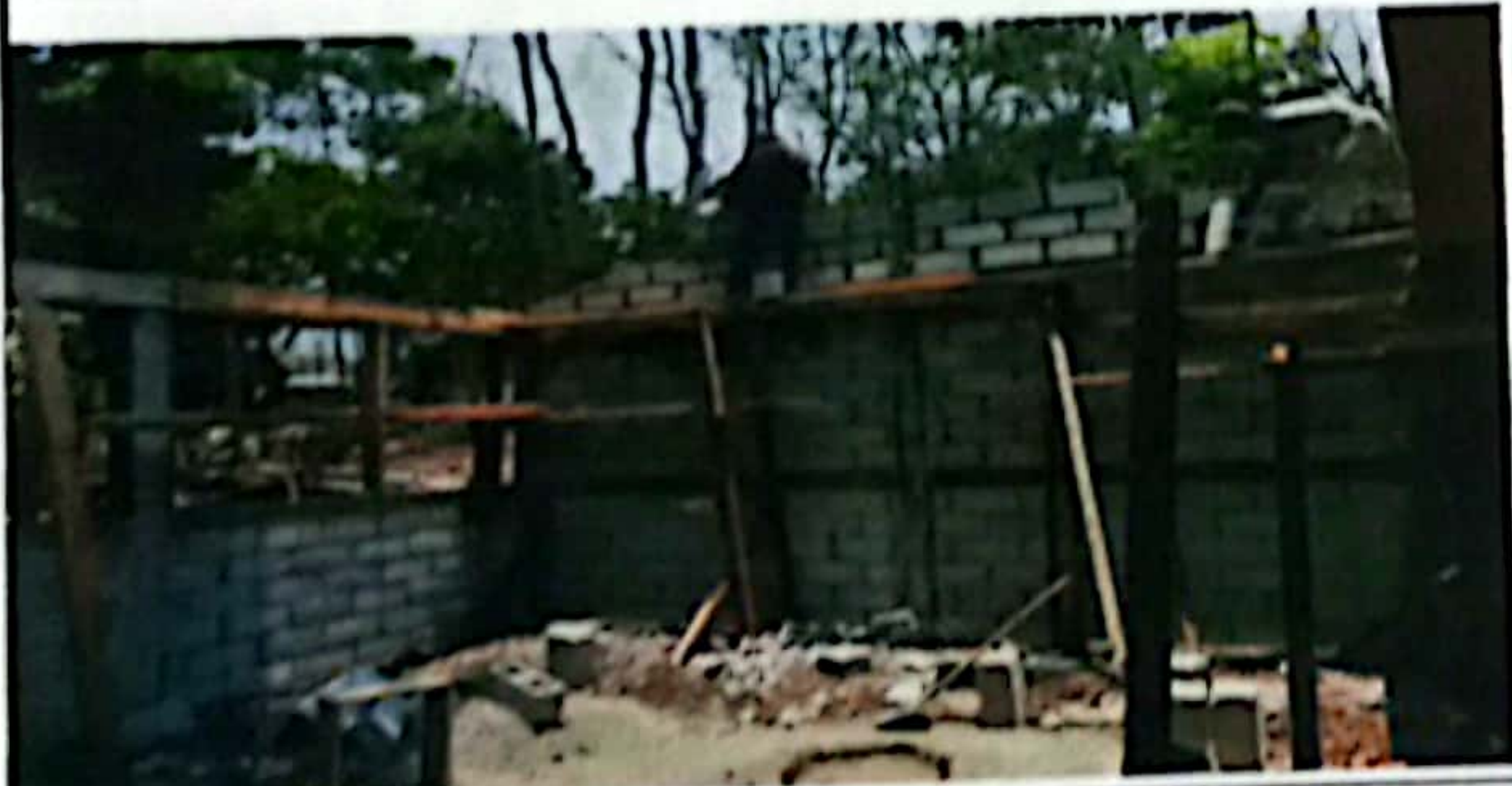
Foto 3: MEJORAMIENTO EN PAREDES MODULO 1
