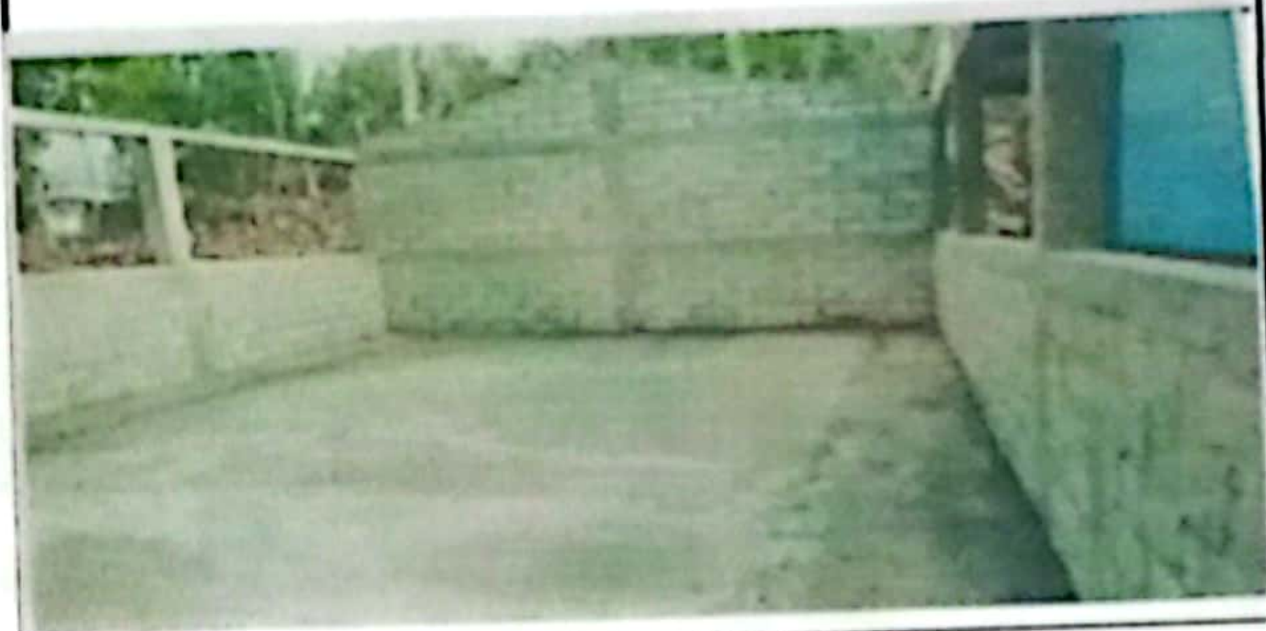
Foto 2: ISNTALACION DE PISO DE CONCRETO DE AULA
