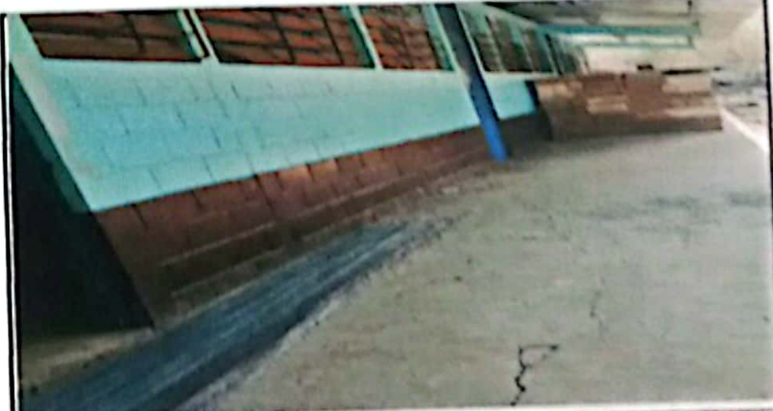
Foto 6: MATERIAL PARA MEJORAMIENTO DE PAREDES
