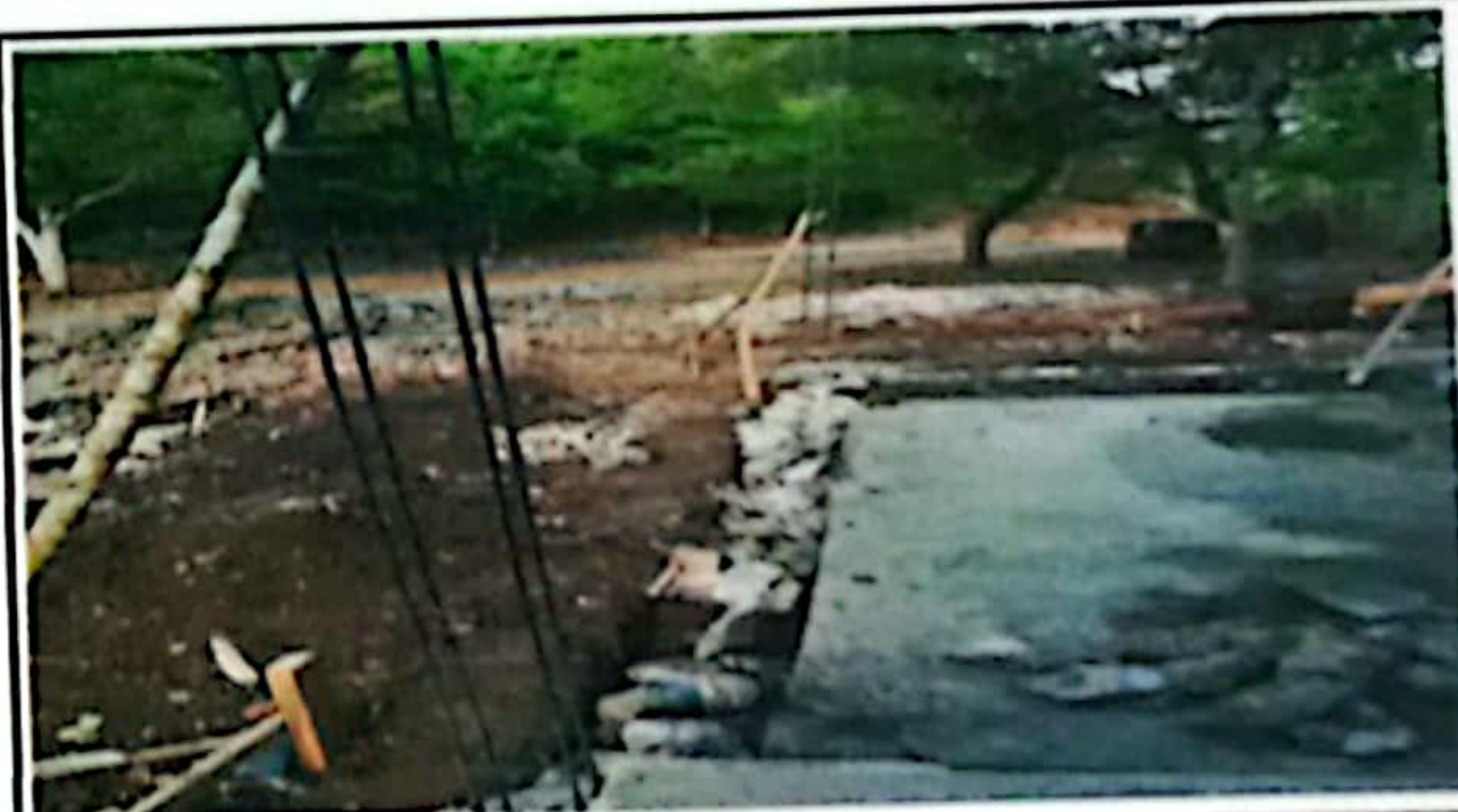
MEJORAMIENTO DE CIMIENTO
